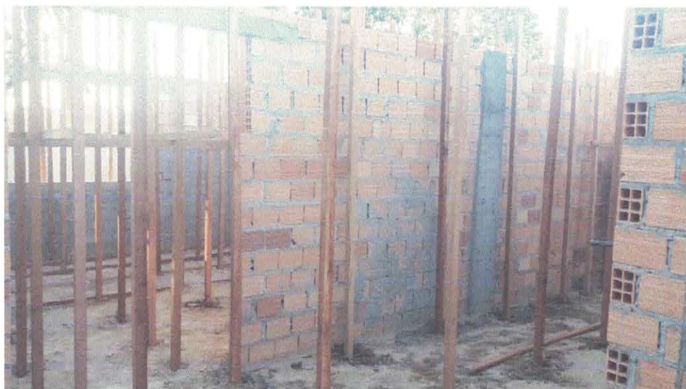
1- Montagem do escoramento da laje
