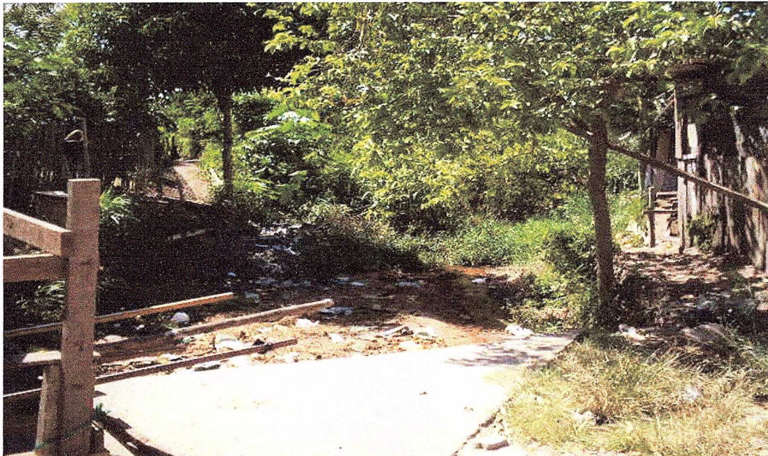
Figura 05 – Situação do córrego Redenção atualmente, trecho de deságue do canal.
