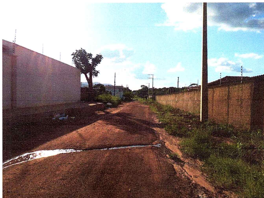
Figura 2- Rua 40 ( 8° 2'8.61"S/ 50° 2'15.01"O)
