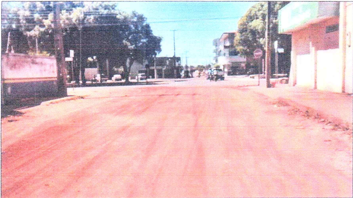
Figura 4 - Rua Walter Noli c/ Av. Thompson Filho (8° 2'30.16"S / 50° 1'54.25"O)
