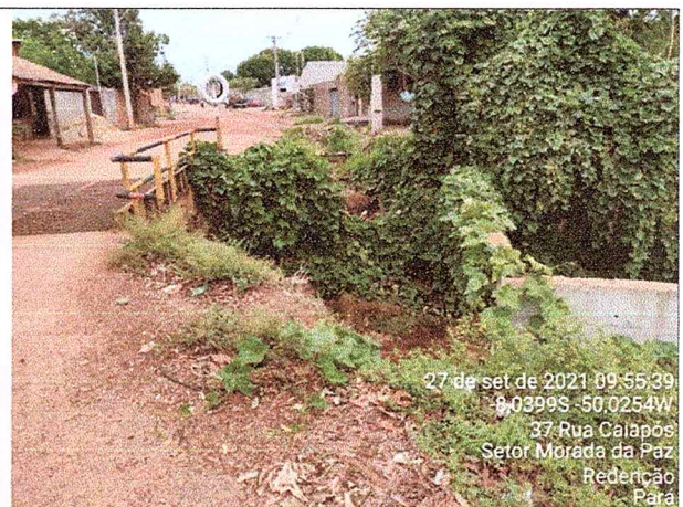
Figura 3 - Vista do local onde será construído 2ª Etapa do canal, parte já com a calha em concreto moldada "in loco".
