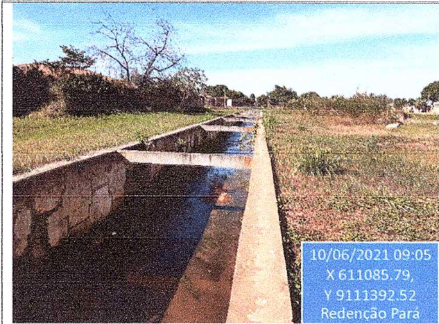
Figura 13 – Trecho da Etapa 01 do Canal Suprema Executado (CALHA)
