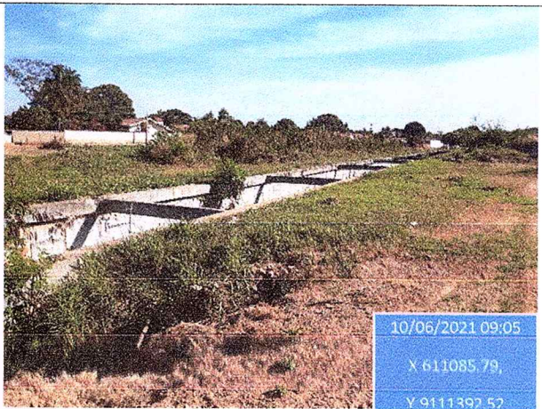
Figura 12 – Trecho da Etapa 01 do Canal Suprema Executado (CALHA)
