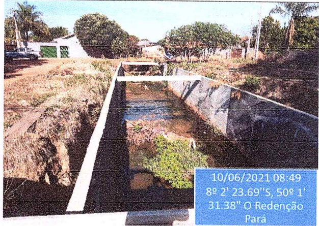
Figura 04 – Parte do Canal concretado da etapa 02 do Canal
