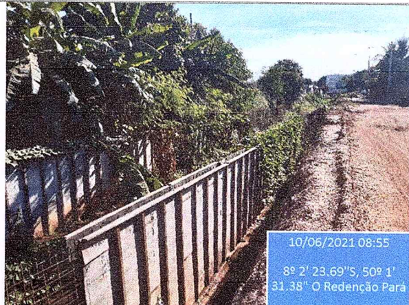
Figura 06 – Trecho da Etapa 02 do Canal Suprema Ferragem com Formas
