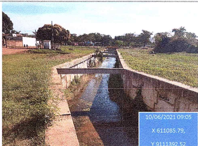
Figura 14 – Trecho da Etapa 01 do Canal Suprema Executado (CALHA)
