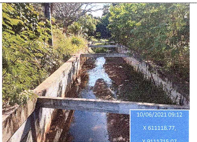
Figura 18 – Trecho da Etapa 01 do Canal Suprema Executada (CALHA)
