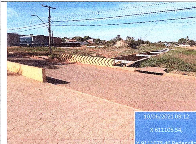
Figura 15 – Trecho da Etapa 01 do Canal Suprema Executada (PONTE 1)
