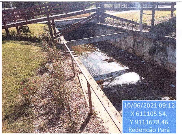
Figura 16 – Trecho da Etapa 01 do Canal Suprema Executado (CALHA)
