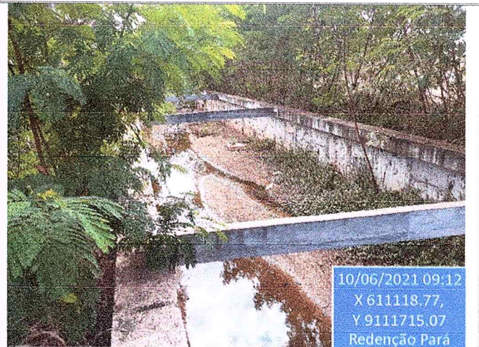
Figura 24 – Trecho da Etapa 01 do Canal Suprema Executado (CALHA)
