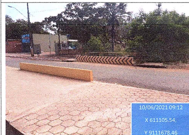
Figura 17 – Trecho da Etapa 01 do Canal Suprema Executada (PONTE 2)
