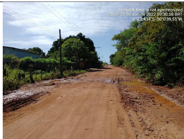
Figura 35/55 – Vista da Av. Marechal Rondon entre a A. Mato Grosso e Vila Gutierrez.
