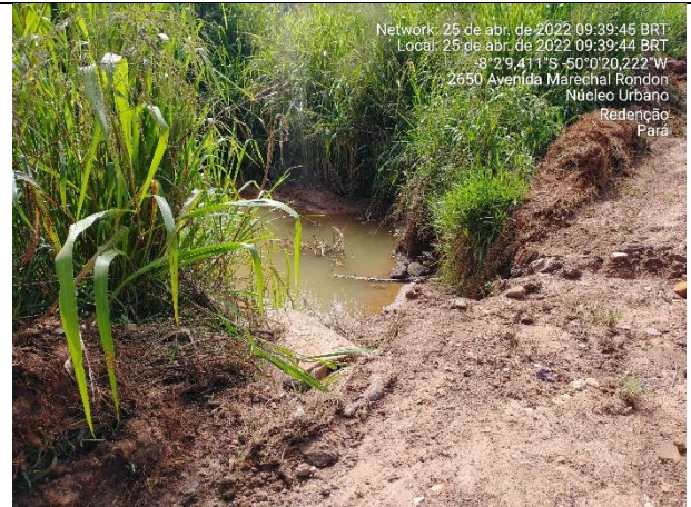
Figura 27/55 – Vista a jusante de BSTC, sem boca, existente na Av. Marechal Rondon entre Av. Hermenegilda da Fonseca e Av. Mato Grosso, o qual será substituído por um BSCC de 2,00m x 2,00m, incluso no Projeto de Pavimentação.
