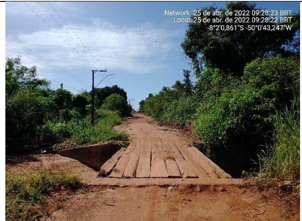
Figura 39/55 – Vista da ponte em madeira existente na Av. Marechal Rondon, próximo a Vila Gutierrez, que será substituída, com recursos próprios da PMR, por uma OAE Ponte em concreto armado nas dimensões da futura pista e com 7m de vão.
