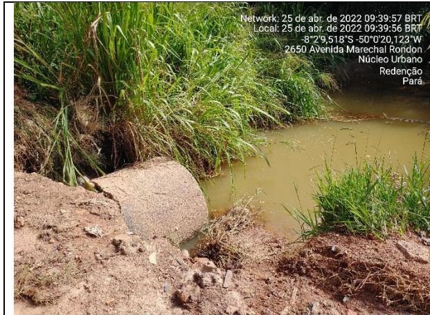
Figura 26/55 – Vista a montante de BSTC, sem boca, existente na Av. Marechal Rondon entre Av. Hermenegilda da Fonseca e Av. Mato Grosso, o qual será substituído por um BSCC de 2,00m x 2,00m, incluso no Projeto de Pavimentação.
