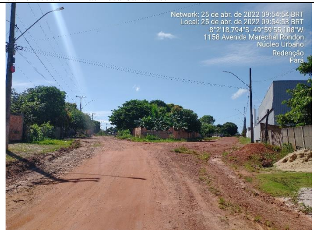
Figura 17/55 – Vista da Av. Marechal Rondon entre Av. Hermenegilda da Fonseca e AvBrás Rosa Carvalho.
